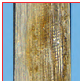
Citelli-tang, glijvlakken van het schuifgedeelte laat wrijfcorrosie-verschijnselen zien
