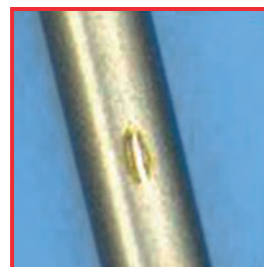
Contactcorrosie: roestvrij staal/roestvrij staal
